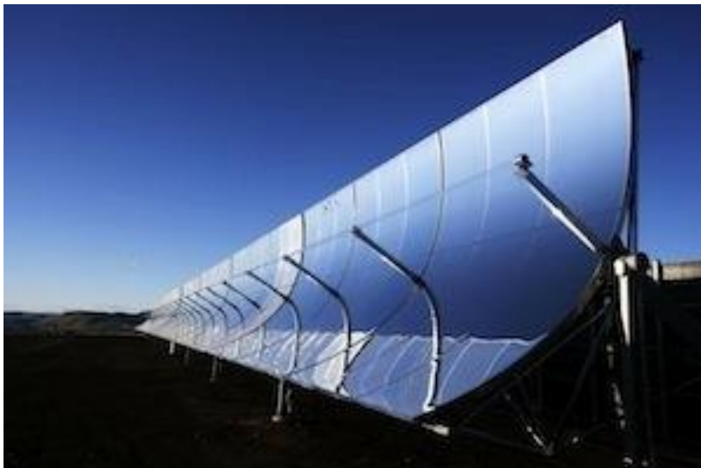
Рисунок 3.3 – Параболічний сонячний колектор
