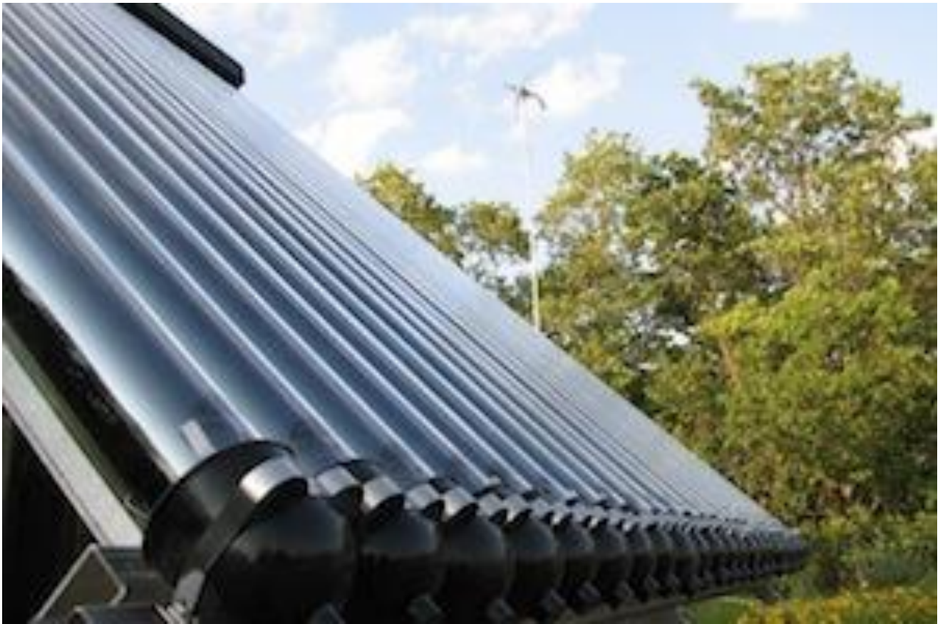
Рисунок 3.2 – Вакуумний колектор.
